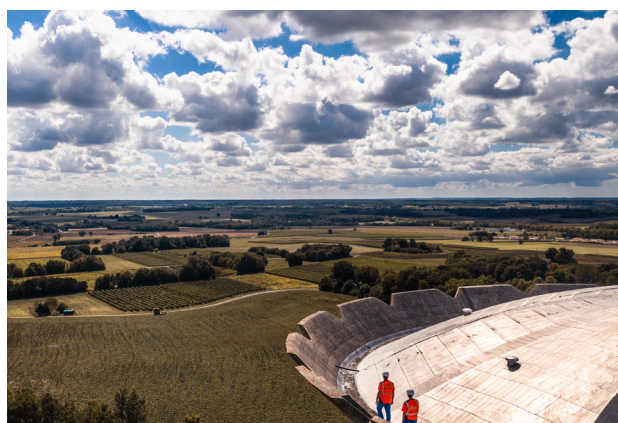
Construit en 2004 pour répondre aux nouveaux enjeux et besoins du territoire, le château d'eau d'Asnières-la-Giraud peut stocker 2 700 m 3 d'eau potable.
